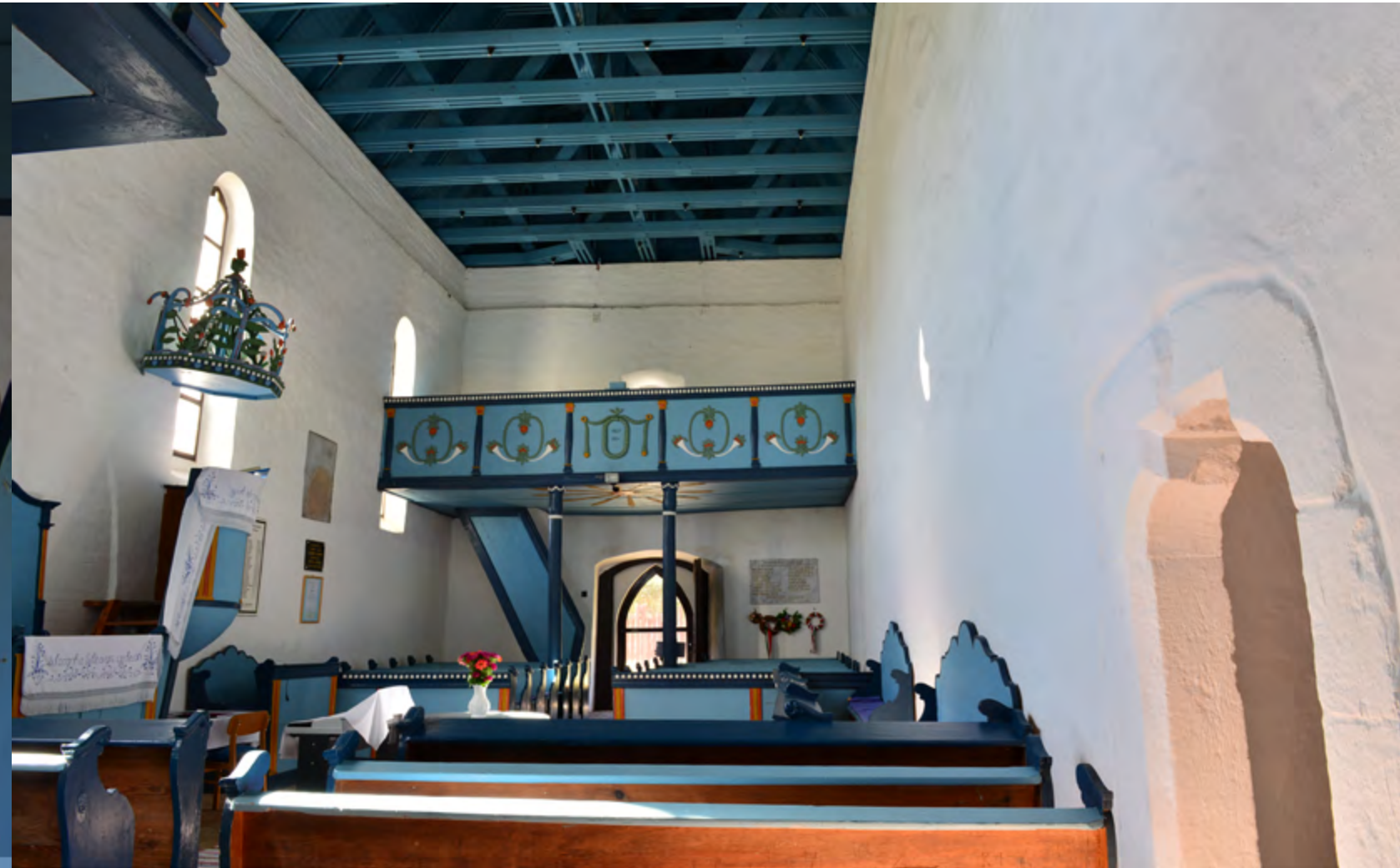
A templom 1990-es években végzett helyreállítása során készült rácsos- tartókból álló mennyezete az eredeti tetőszerkezet elemeivel megegyezően került kialakításra, amely rendkívül különleges látványt nyújt.
