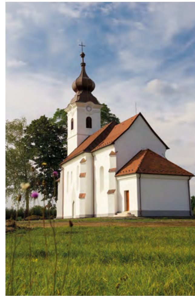
A középkori eredetre utaló jelek, úgymint a hajó és a szentély sarkain álló lépcsős támpillér, a bejárat fölötti háromszög alakú vakolat oromdísz, két oldalán keskeny, mély béléttű gótikus résablakkal.
